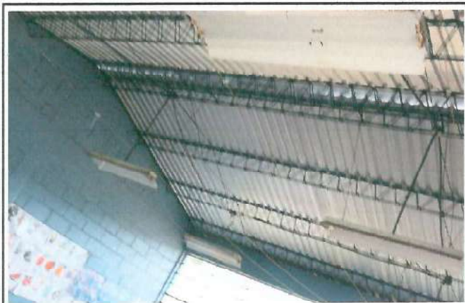
Foto 3: REPARACIÓN DE SISTEMA ELÉCTRICO.
