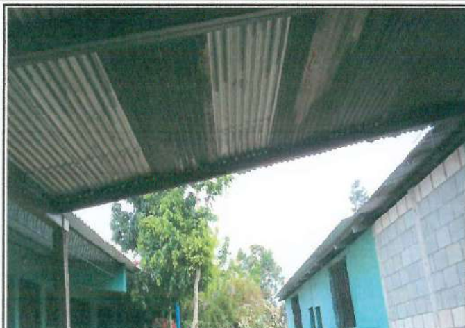
Foto 1: MEJORAMIENTO DE ESTRUCTURA Y TECHADO TIPO PÓRTICO DE PATIO.
