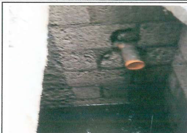
Foto 2: REPARACIÓN DE RED DE DRENAJE SANITARIOS Y ACCESORIOS.
