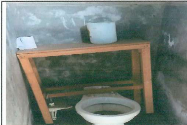
Foto 4: REPARACIÓN DE RED DE DRENAJE SANITARIOS Y ACCESORIOS.
